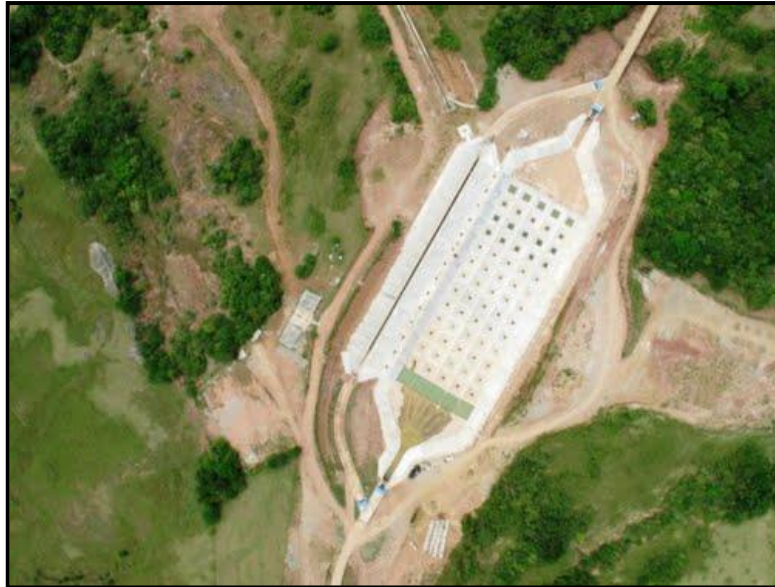
Foto 18. Vista aérea Excluser de Sedimentos Distrito de Riego Triángulo del Tolima.
