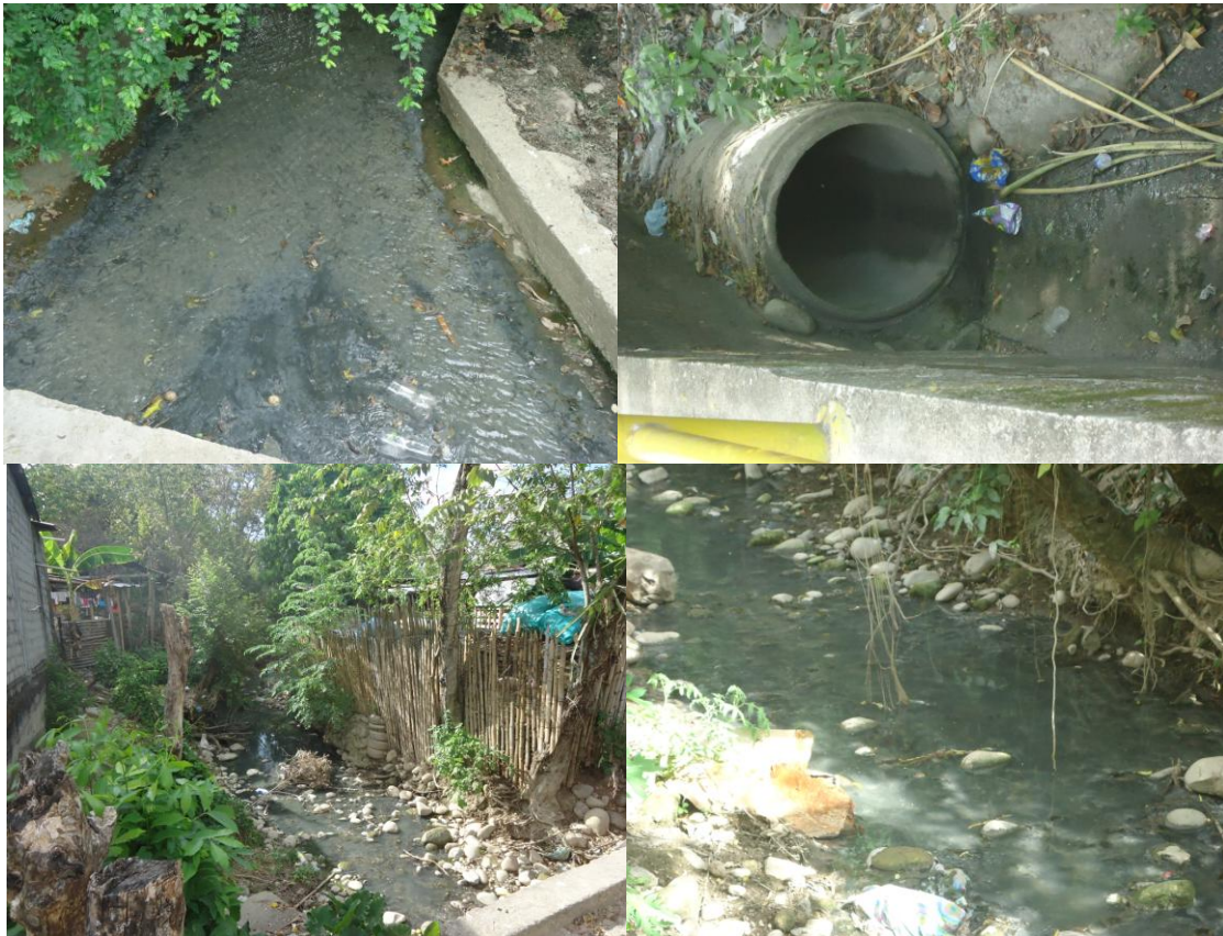
Foto 24. Vertimiento de Residuos Líquidos Zona Urbana Municipio de Coyaima por la Quebrada Masato.
