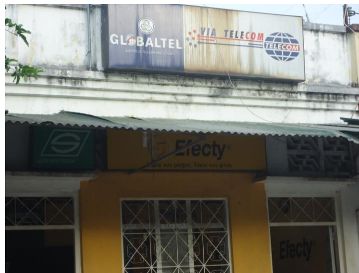
Foto 33. Instalaciones de Globaltel – Telecom.
