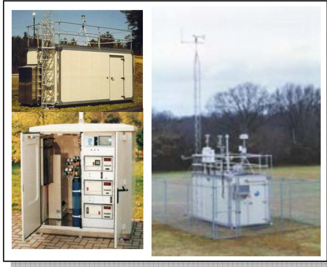
Figura 12.7. Cabinas de Monitoreo equipos automáticos (Fotografías Internet)
