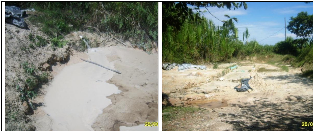
Foto 130. Piscinas de sedimentación FIT S.A.
