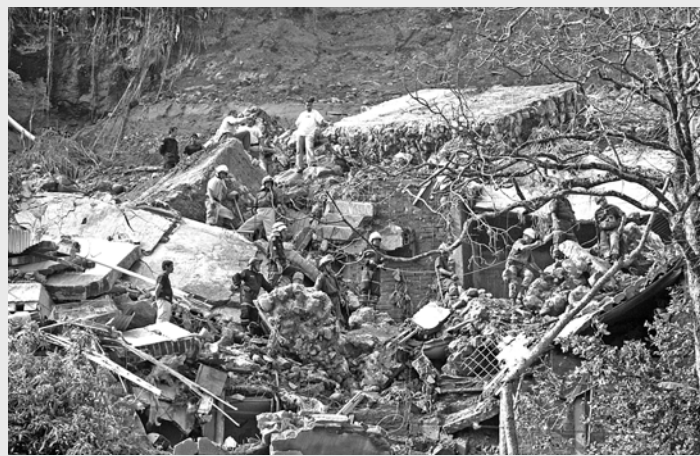
SECTOR ALTO de la cuesta de Chapinero, donde colapso el muro en concreto ciclopeo, que origino la destrucción de viviendas y la pérdida de vidas humanas.
