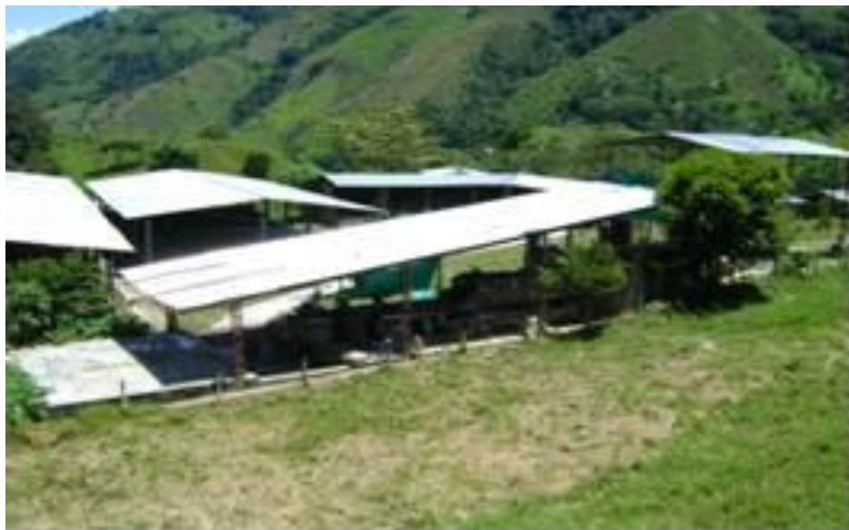
Foto 11. Planta de tratamiento Municipio de Río Blanco
